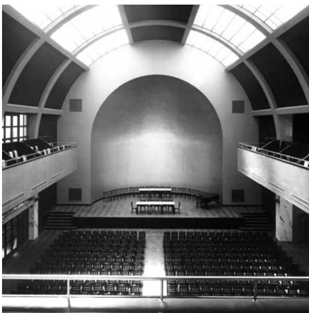
Fig. 12. J. Gočár, Railway-workers building in Hradec Králové, 1933–1934
